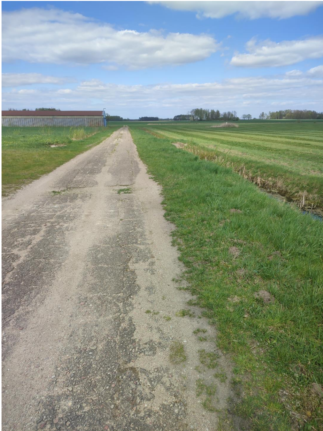
Fot. 3. Rowy po obu stronach drogi w okolicach hangarów.
