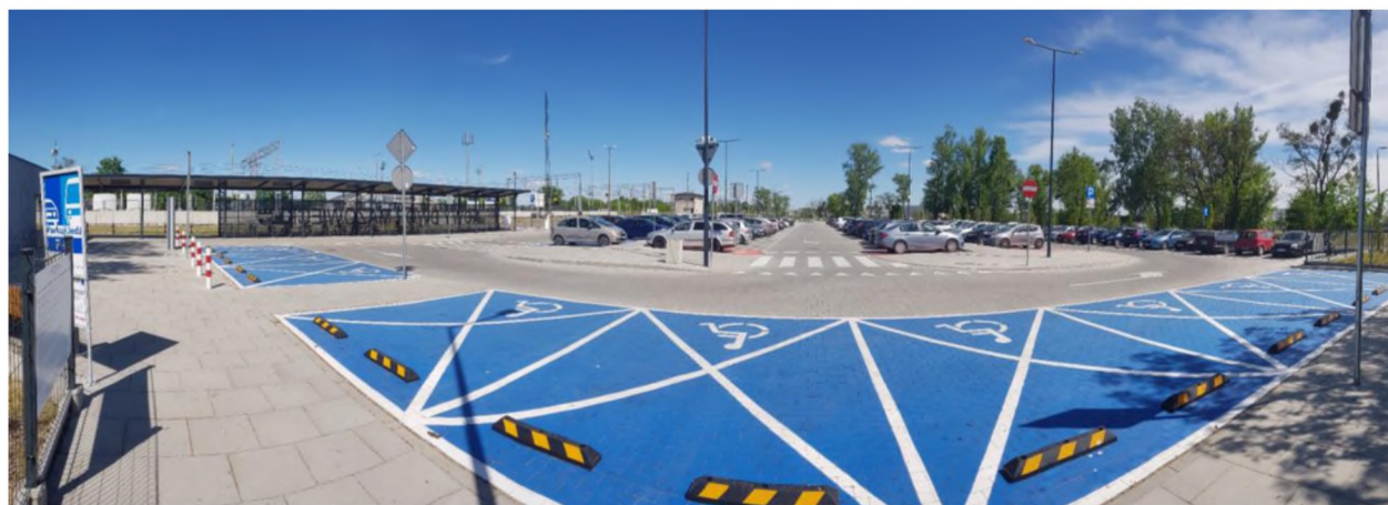
Rys. 2.3 Parking P+R w Nowym Dworze Mazowieckim
